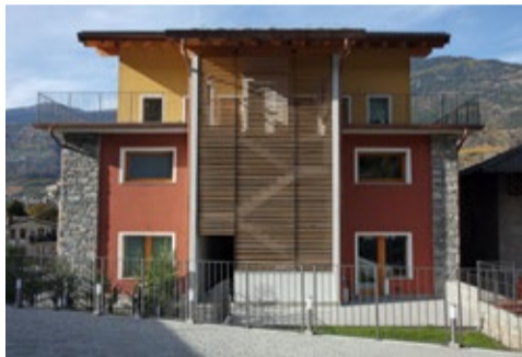
Ultima realizzazione Edileco - Aymavilles (Ao)
